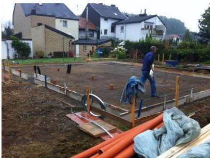
Die Erdarbeiten wurden begonnen, dann im Anschluss folgten das Betonieren der Bodenplatte und das Mauern der Tragenden Wände.
